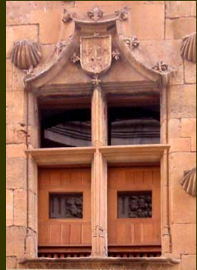
Fachada Casa de las Conchas SALAMANCA
